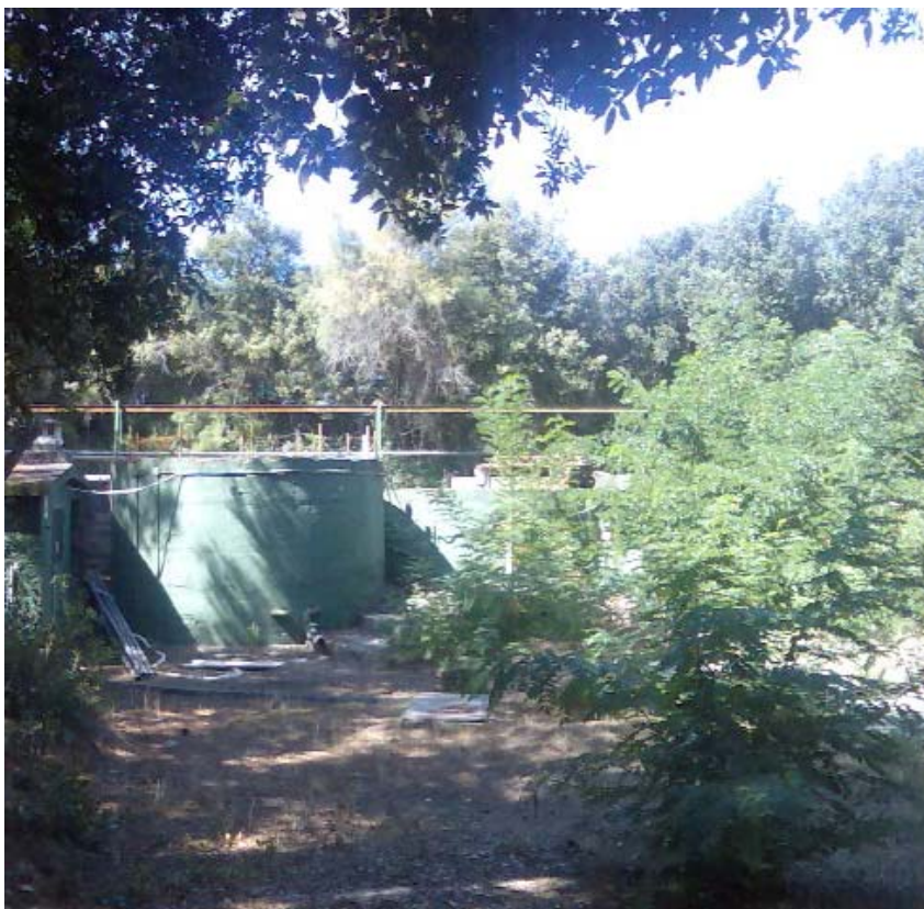
impianto di depurazione reflui dell'ex club mediterranée
