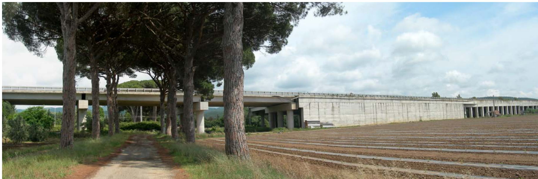
viale Serristori, la piana agricola e il fascio infrastrutturale
