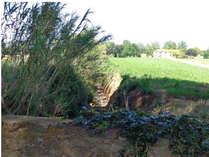
Figura 7 - La foto illustra il Fosso della Casa Rossa individuato come “Corridoio ecologico fluviale da riqualificare”.
