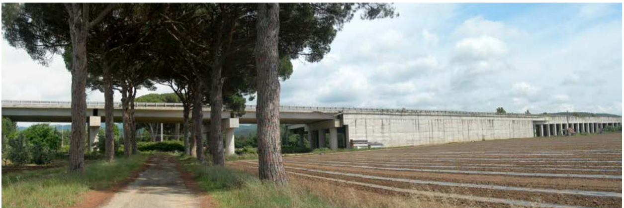
Figura 4 - Viale Serristori e fascio infrastrutturale
