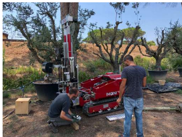
Postazione prova penetrometrica statico-dinamica - CPT 3/DPSH3
