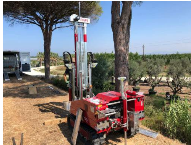
Postazione prova penetrometrica dinamica - DPSH 1
