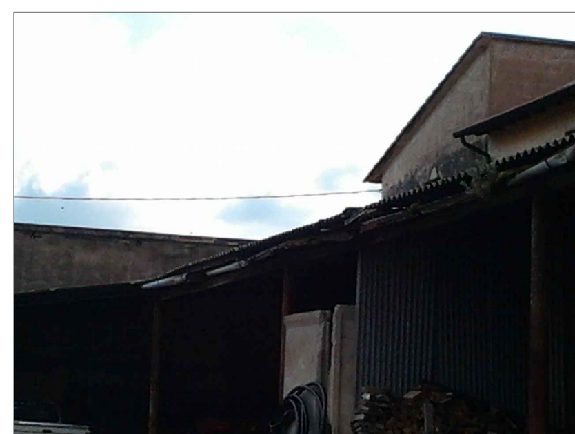
FOTO 2 LINEA ELETTRICA A BASSA TENSIONE
