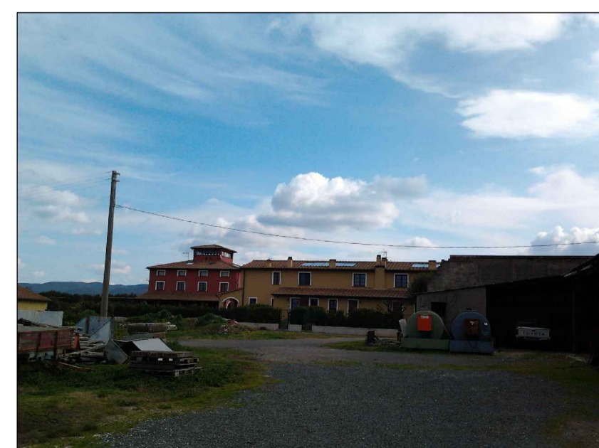
FOTO 1 LINEA ELETTRICA A BASSA TENSIONE
