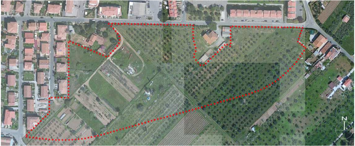
Foto area dell'area di intervento
