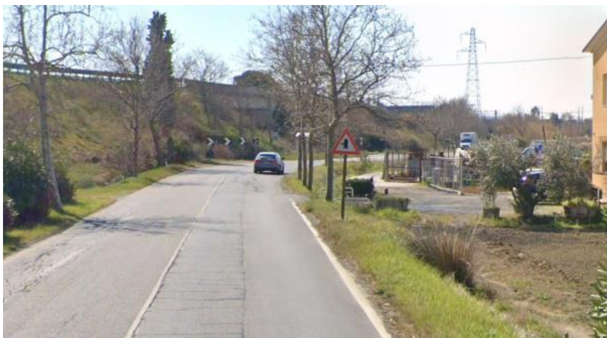
Figura 8 – Vecchia Aurelia a fianco della quale si intervenire con tipologica B3
