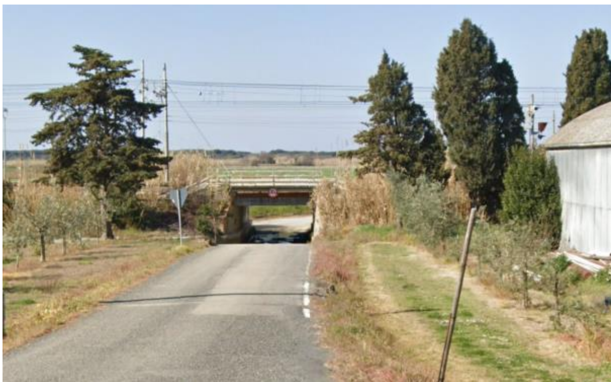
Figura 6 – Sottopasso esistente Via degli Orti
