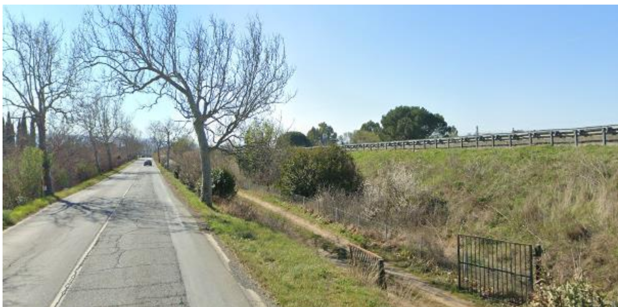
Figura 17 – Tratto tra il rilevato stradale della statale a ovest e la SP39 Vecchia Aurelia ad est
