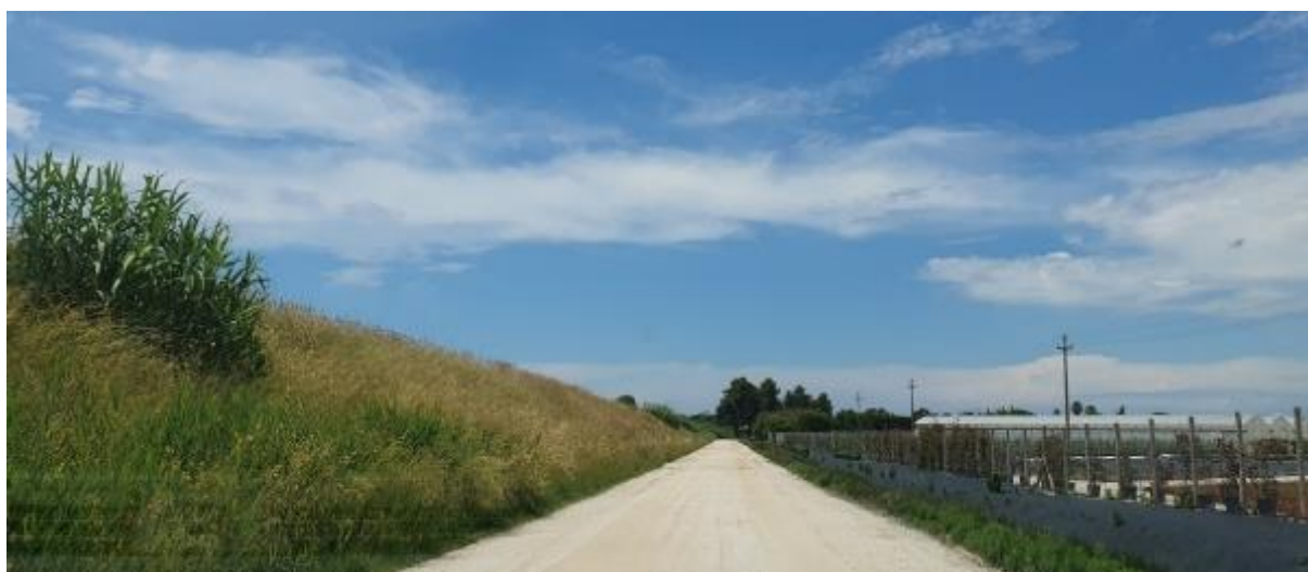
Figura 33 – Viabilità esistente a servizio di un vivaio
