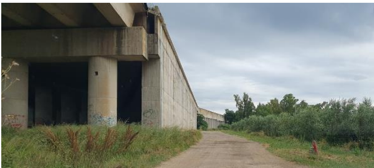
Figura 37 –Viadotto della SS1 e attraversamento ferroviario del Fosso Acqua Calda
