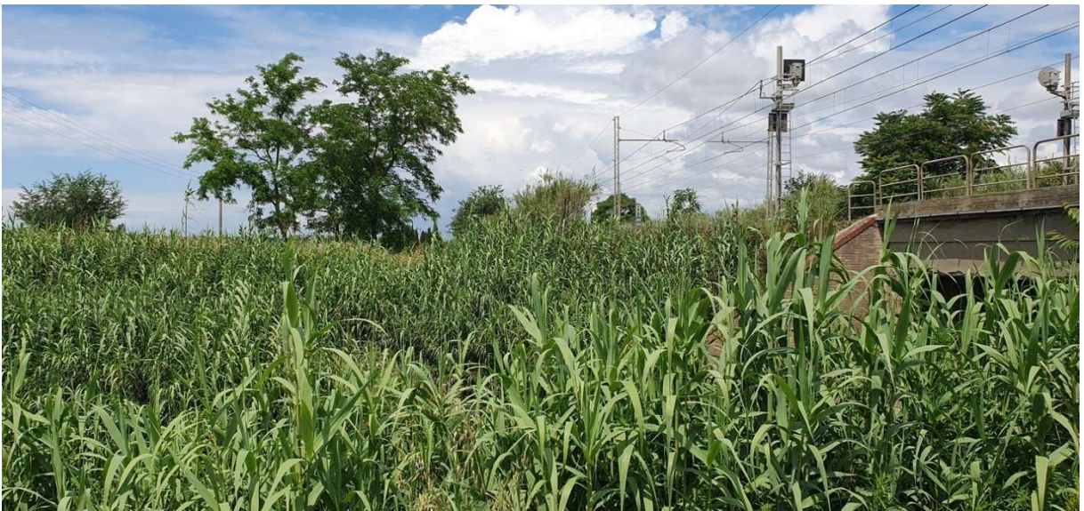
Area oggetto di intervento con nuovo ponte e pista in affiancamento al rilevato ferroviario
