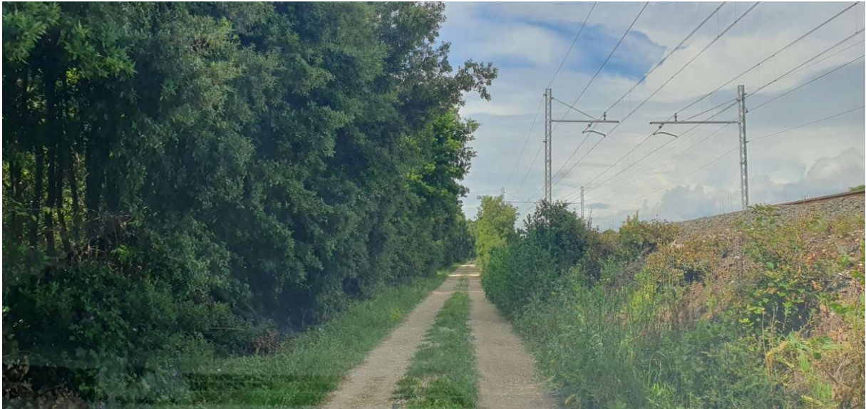
Viabilità esistente in affiancamento al rilevato ferroviario
