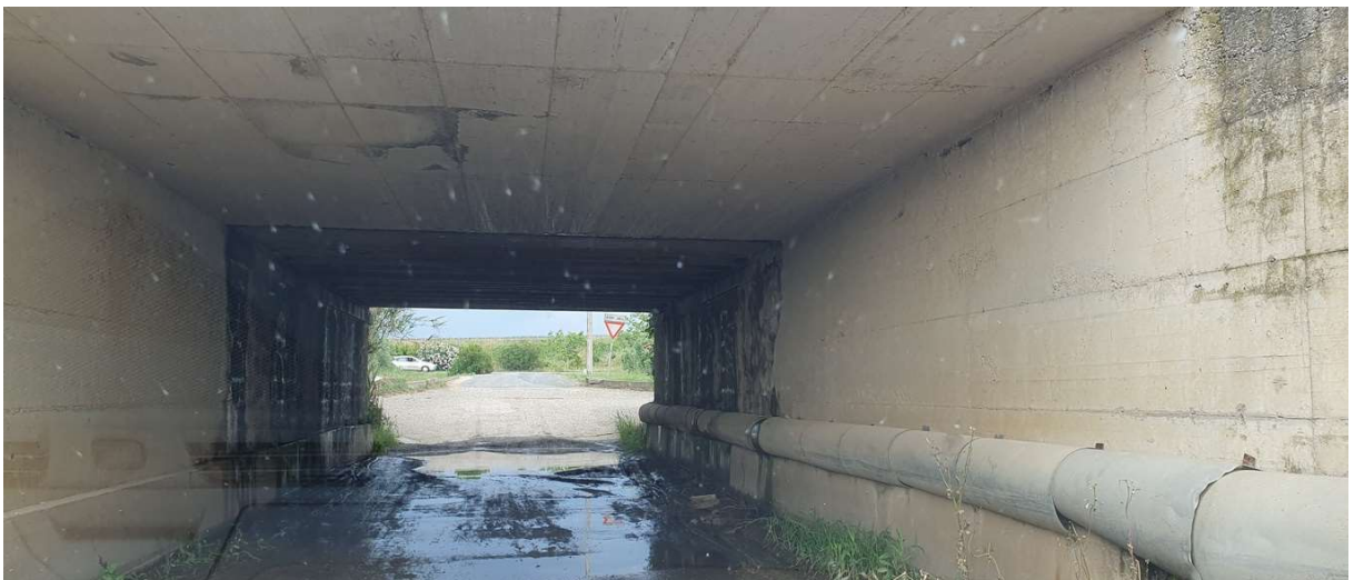
Vista sottopasso esistente
