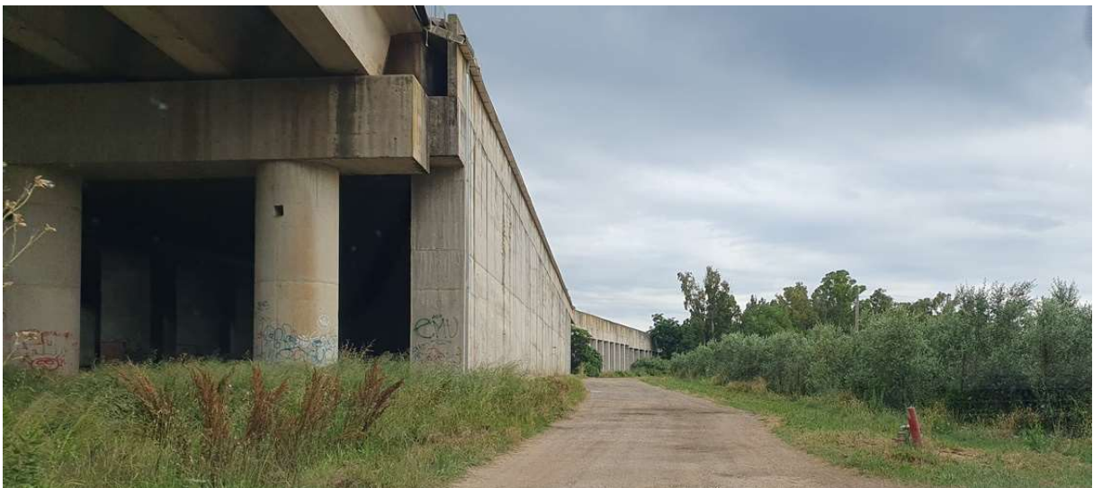
Vista viabilità ai piedi del manufatto stradale
