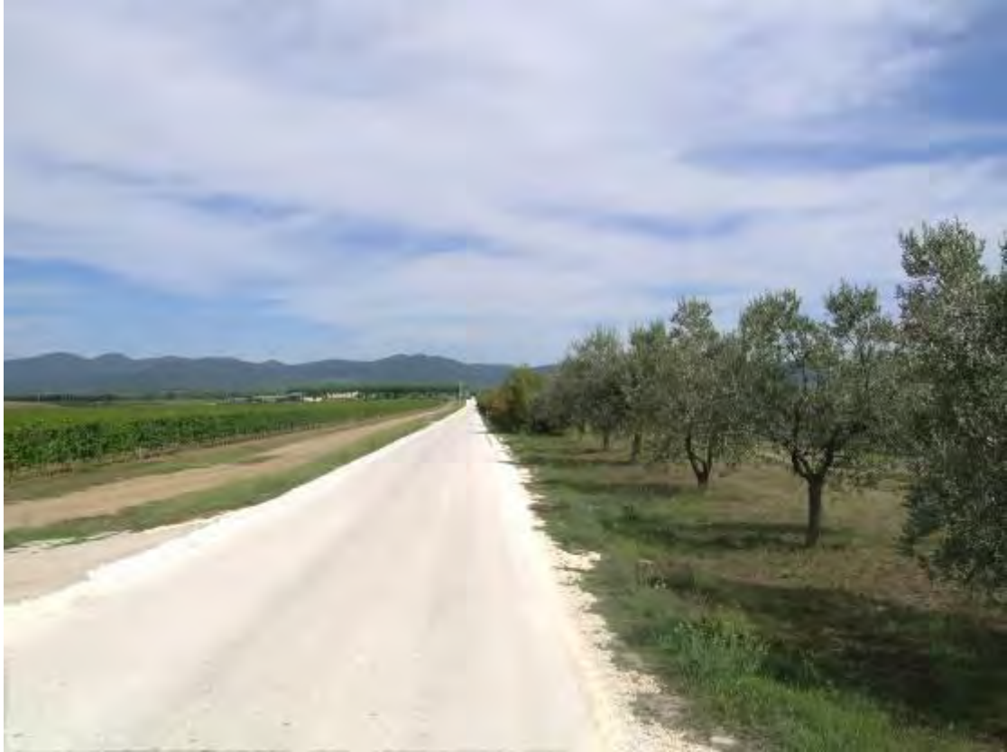
Foto 09 – foto particolare viabilità rurale esistente – strada principale di accesso bordata con olivi e a seguire con arbusti
