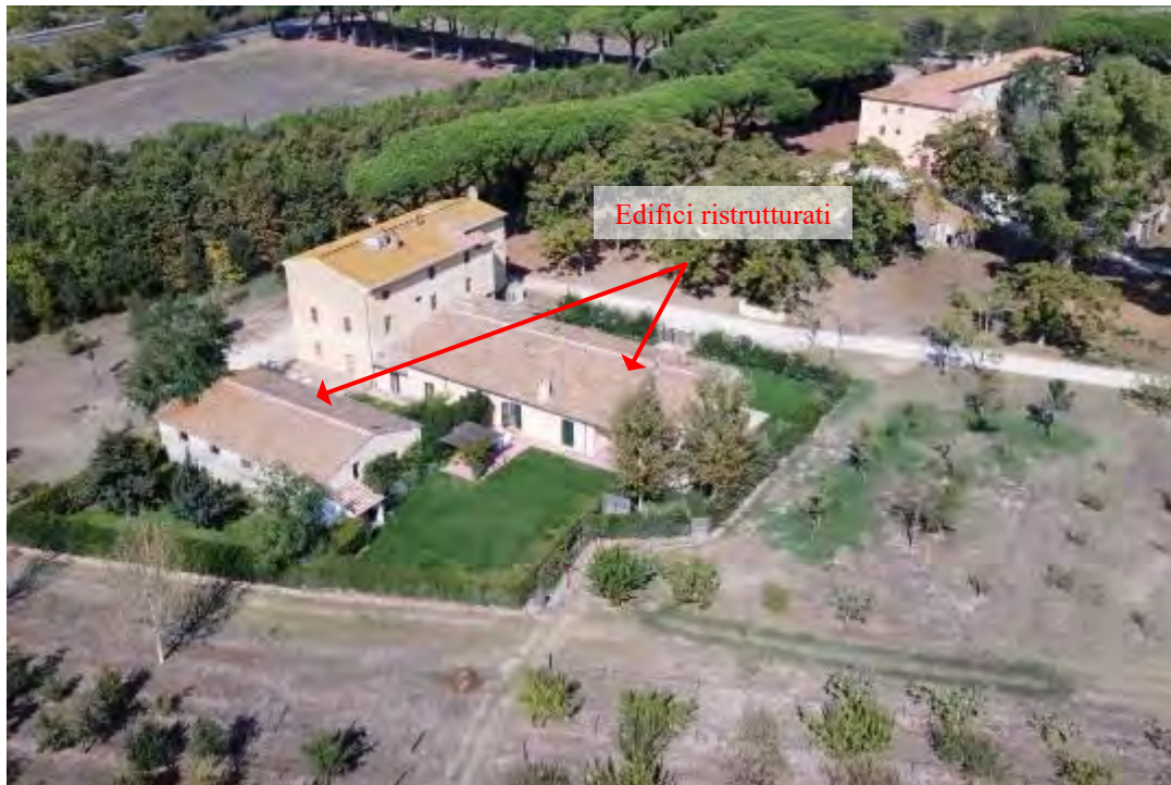
Foto 04 – Interno Podere Belvedere – edifici ristrutturati
