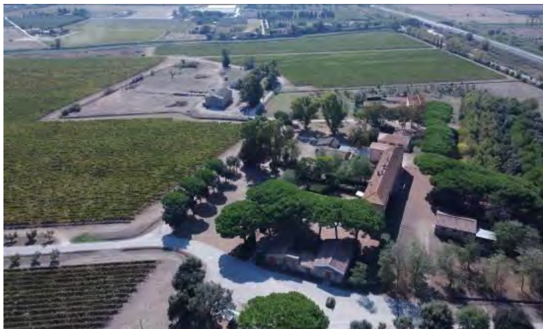
Foto 02 – vista d’insieme dall’Aurelia del Nucleo Edilizio Belvedere, a destra i fabbricati produttivi costruiti negli anni '70.
