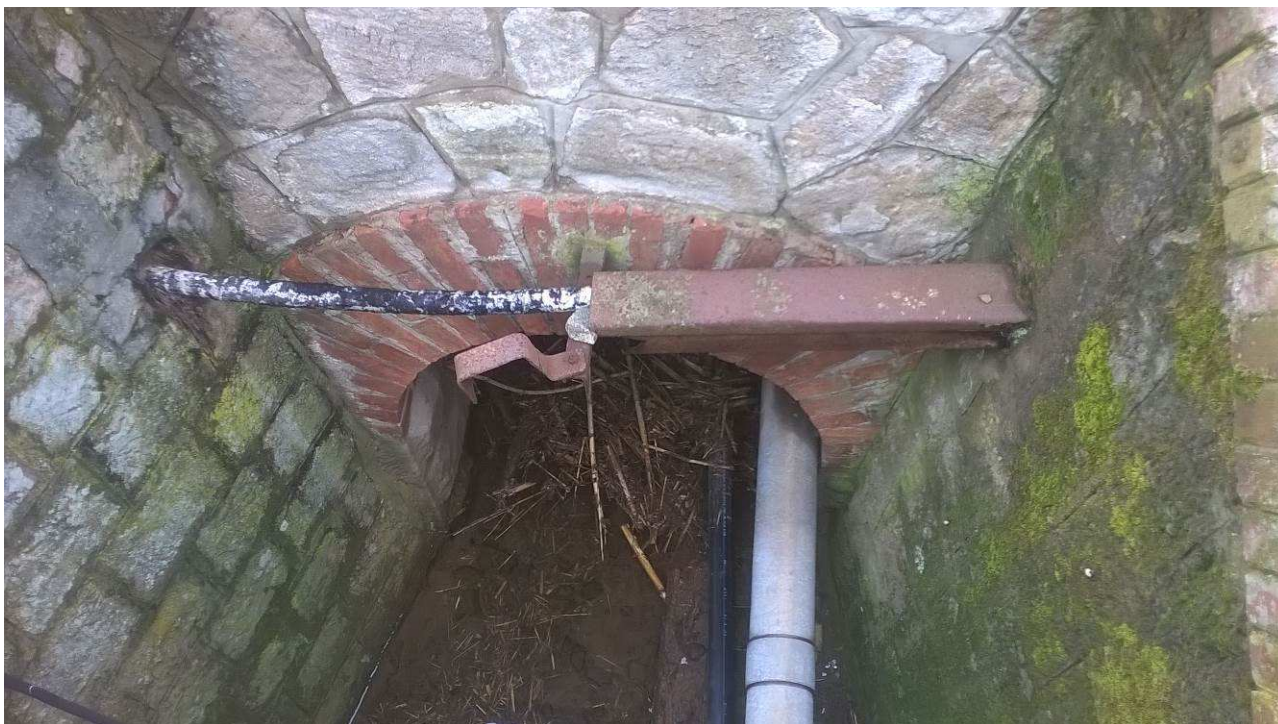
Figura 31 – Manufatto di attraversamento della linea ferroviaria Livorno-Roma (lato valle)
