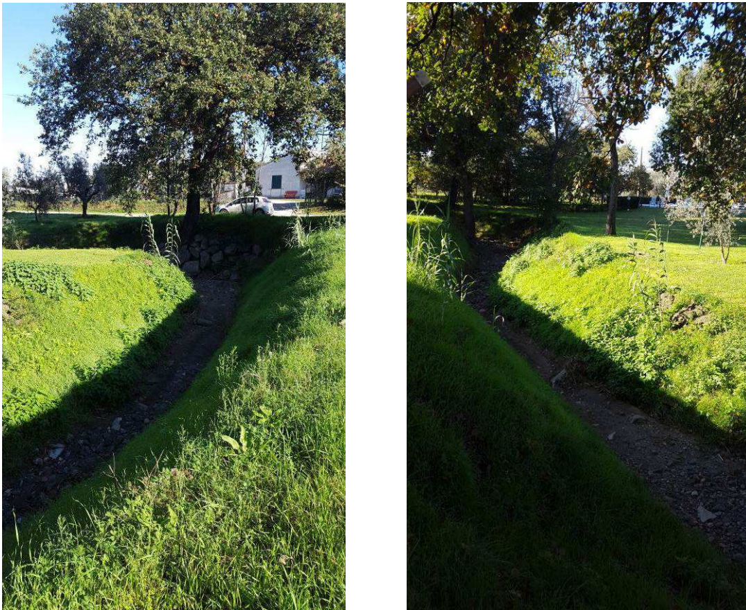
Figura 11 - Fosso ai Molini, sezioni regolari di forma trapezia nella parte mediana del bacino
