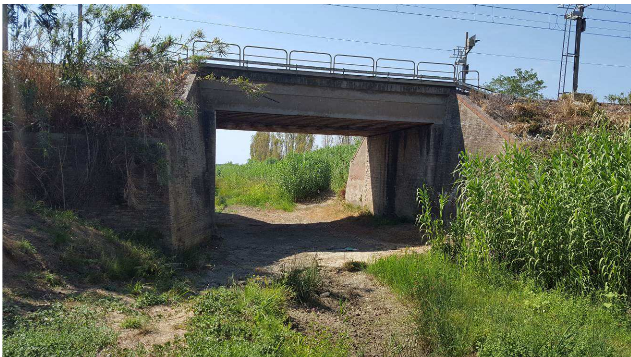
Figura 18 - Fosso Bolgheri in corrispondenza dell'attraversamento della linea ferroviaria
