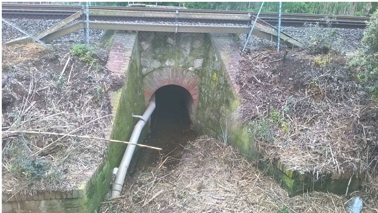
Figura 32 – Manufatto di attraversamento della linea ferroviaria Livorno-Roma (lato monte)
