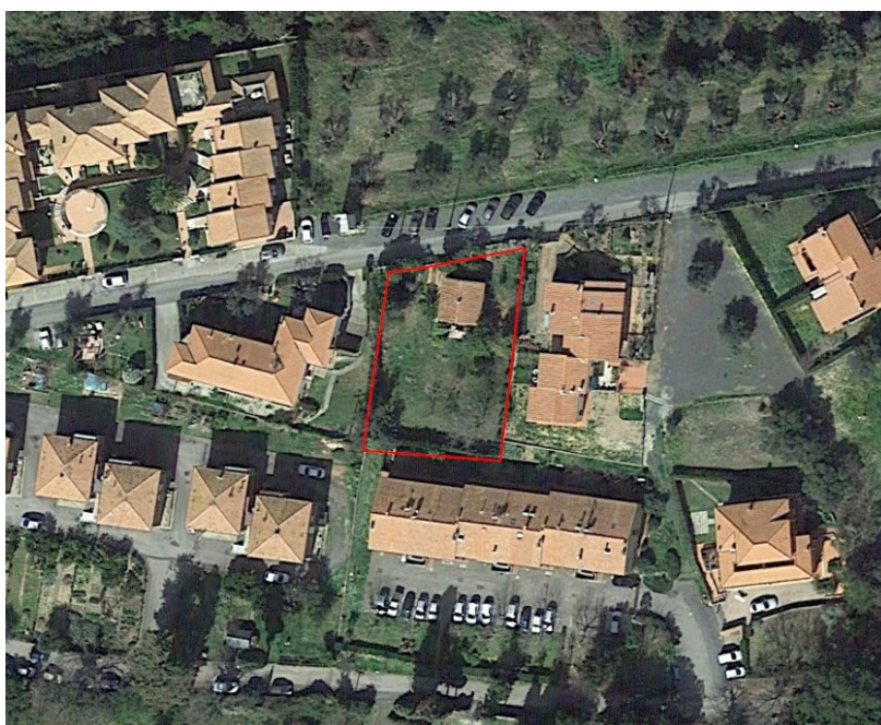
Stato attuale dell'area in esame
