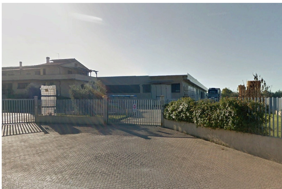
Stato attuale dell'area in esame
