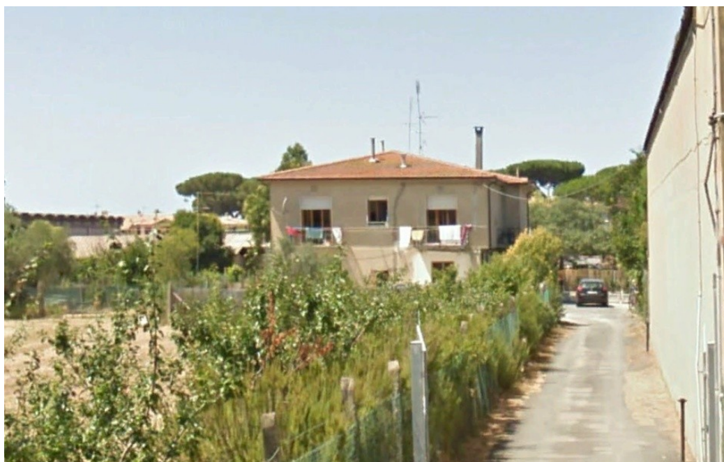
Stato attuale dell'area in esame
