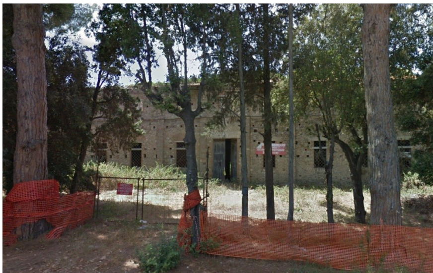
Stato attuale dell'area in esame
