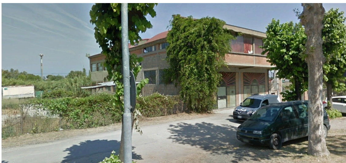
Stato attuale dell'area in esame
