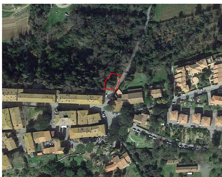
Stato attuale dell'area in esame
