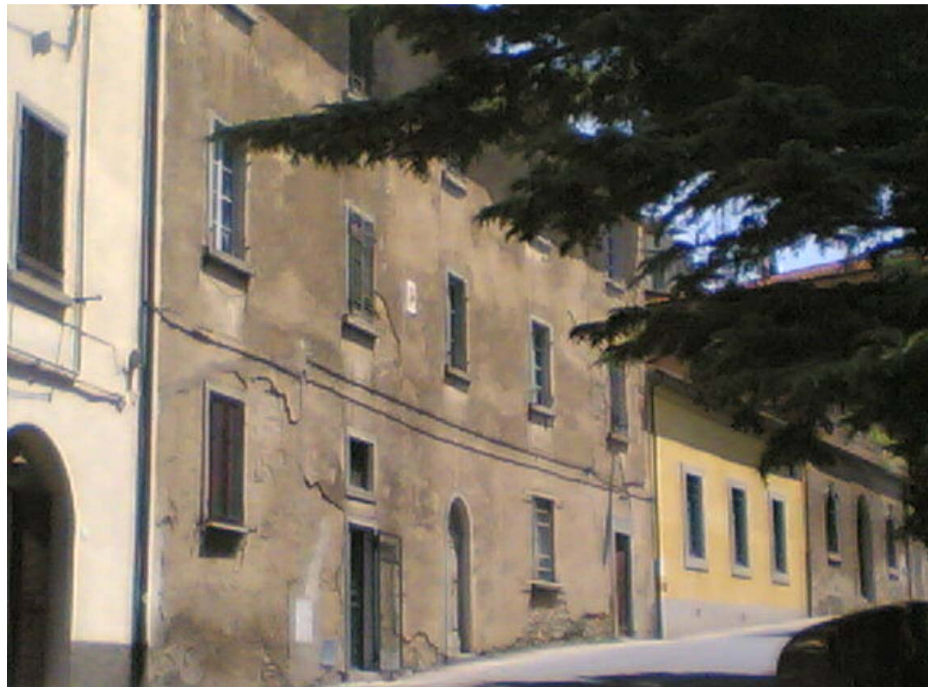
Fig.20 - Edificio da recuperare e ristrutturare a Castagneto Carducci
