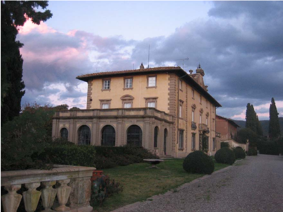
Tipologia palazzo storico
