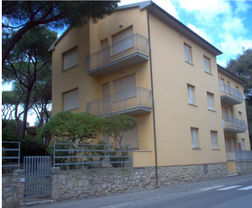
Tipologia edificio condominiale
