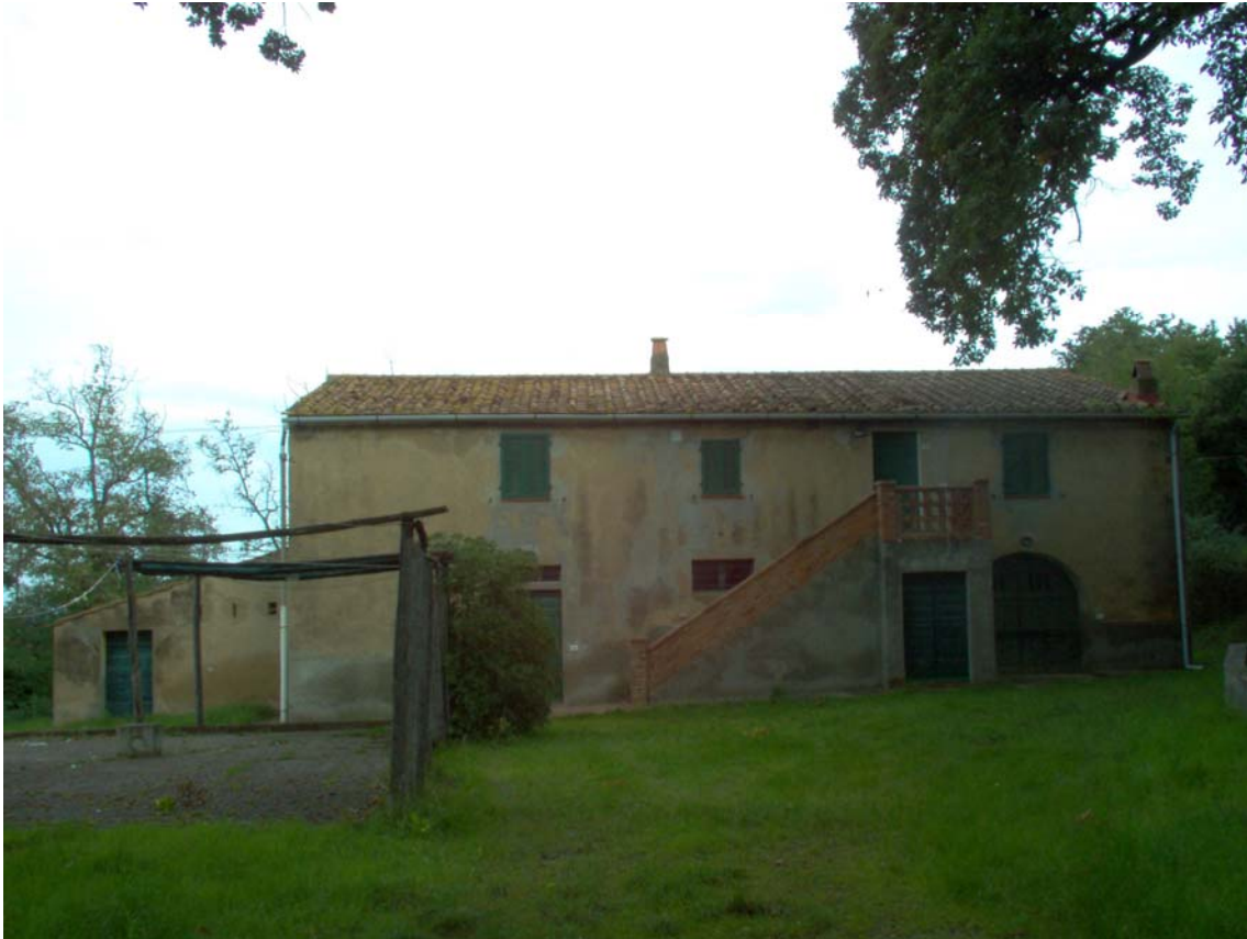
Tipologia edificio rurale
