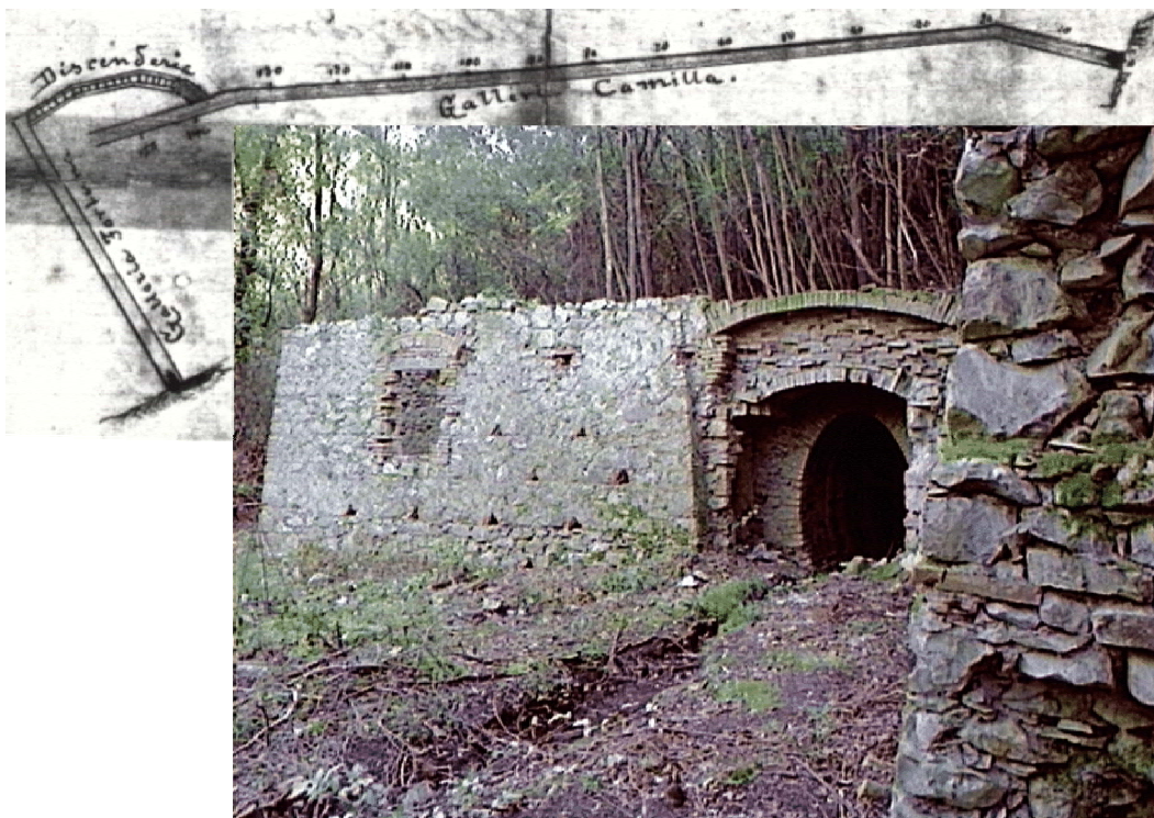
Fig. 2. Ingresso della Miniera Schneider come si presenta oggi con la mappa della stessa realizzata dall'ingegnere Aroldo Schneider nel 1901.
