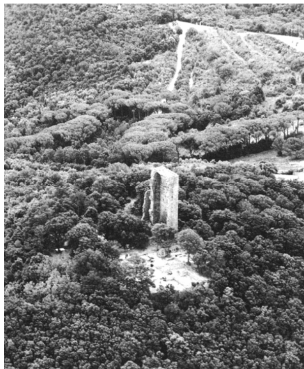
Immagine 2.12: Foto aerea della torre
